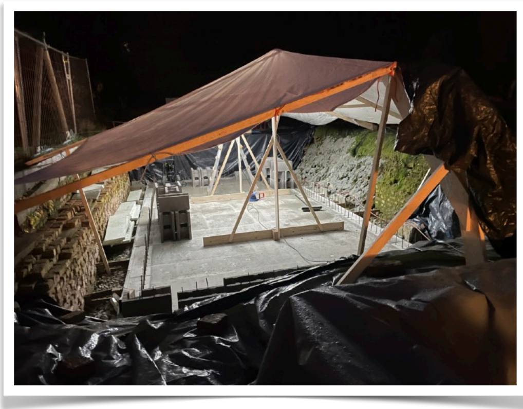
Poolwände/Pooltreppe im Winter gemauert
