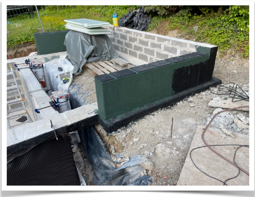
Stützmauer (65cm) / Podest
